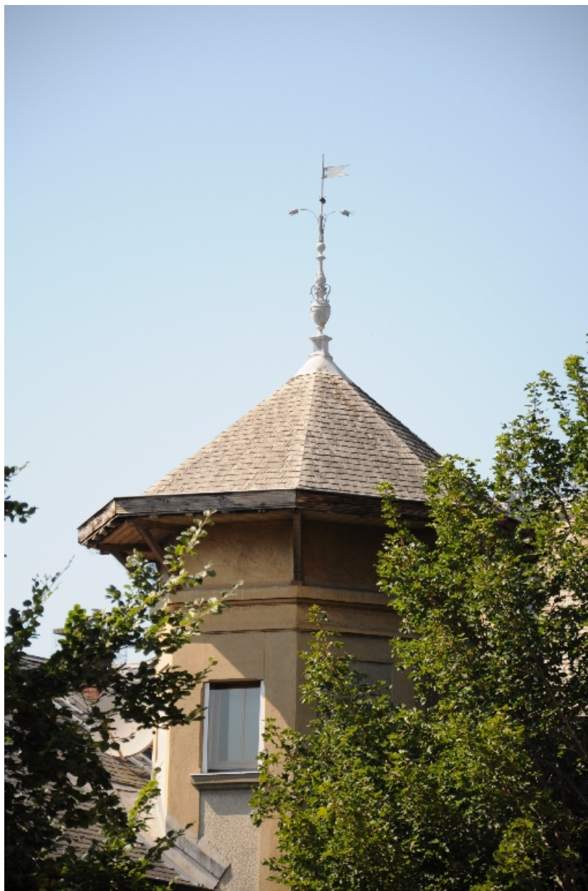
Couverture en croupe polygonale et épi de faîtage de la tour
