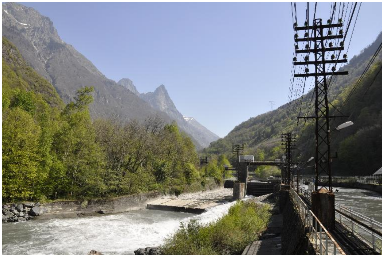
Vue du canal de Rioupéroux
