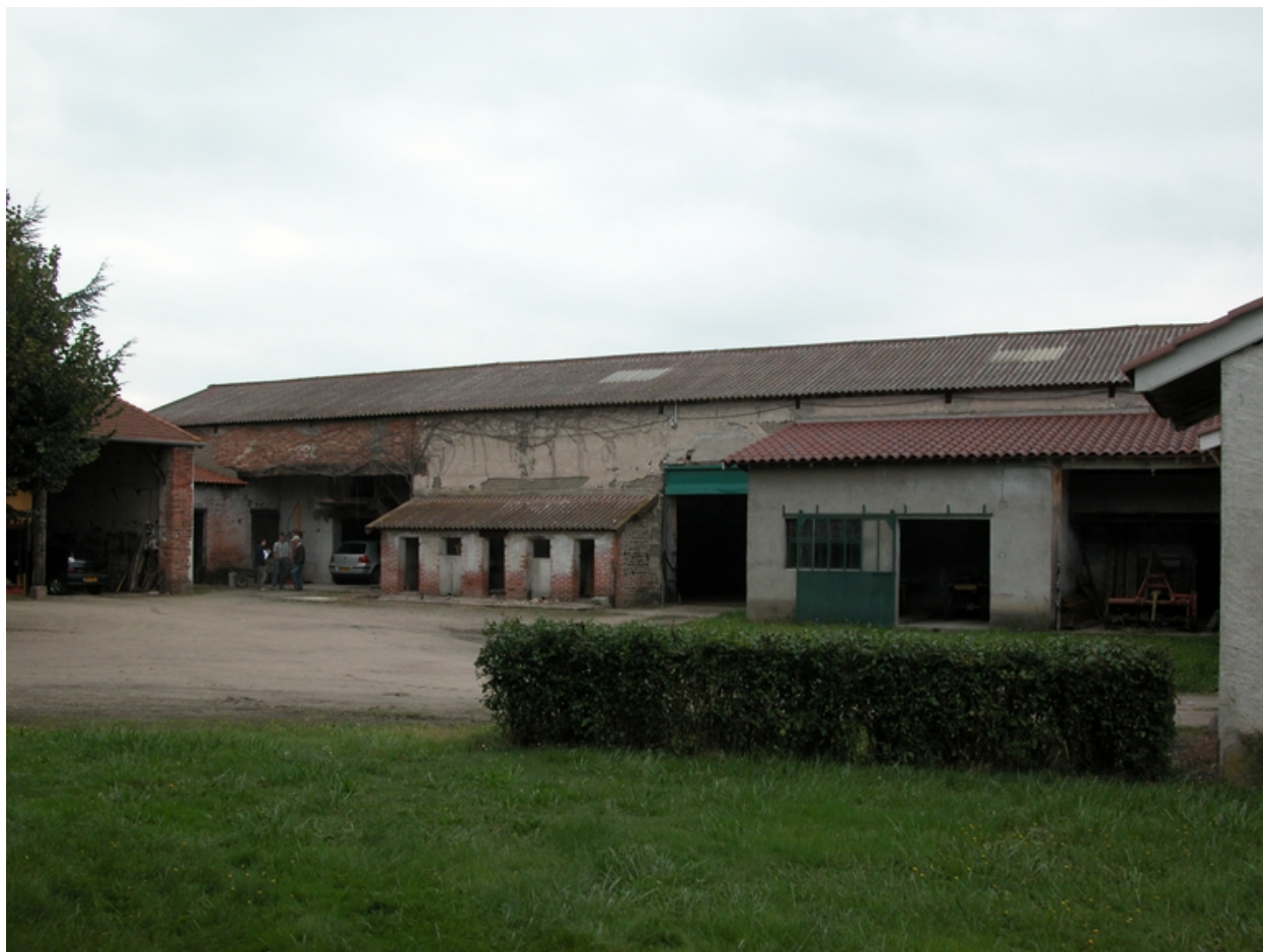
Vue de la grange-étable nord, depuis la cour.
