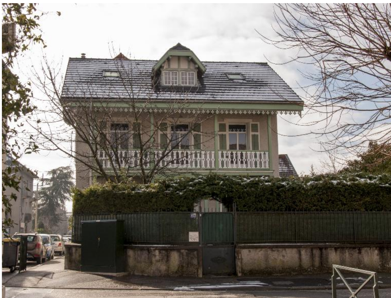
Façade principale (nord)
