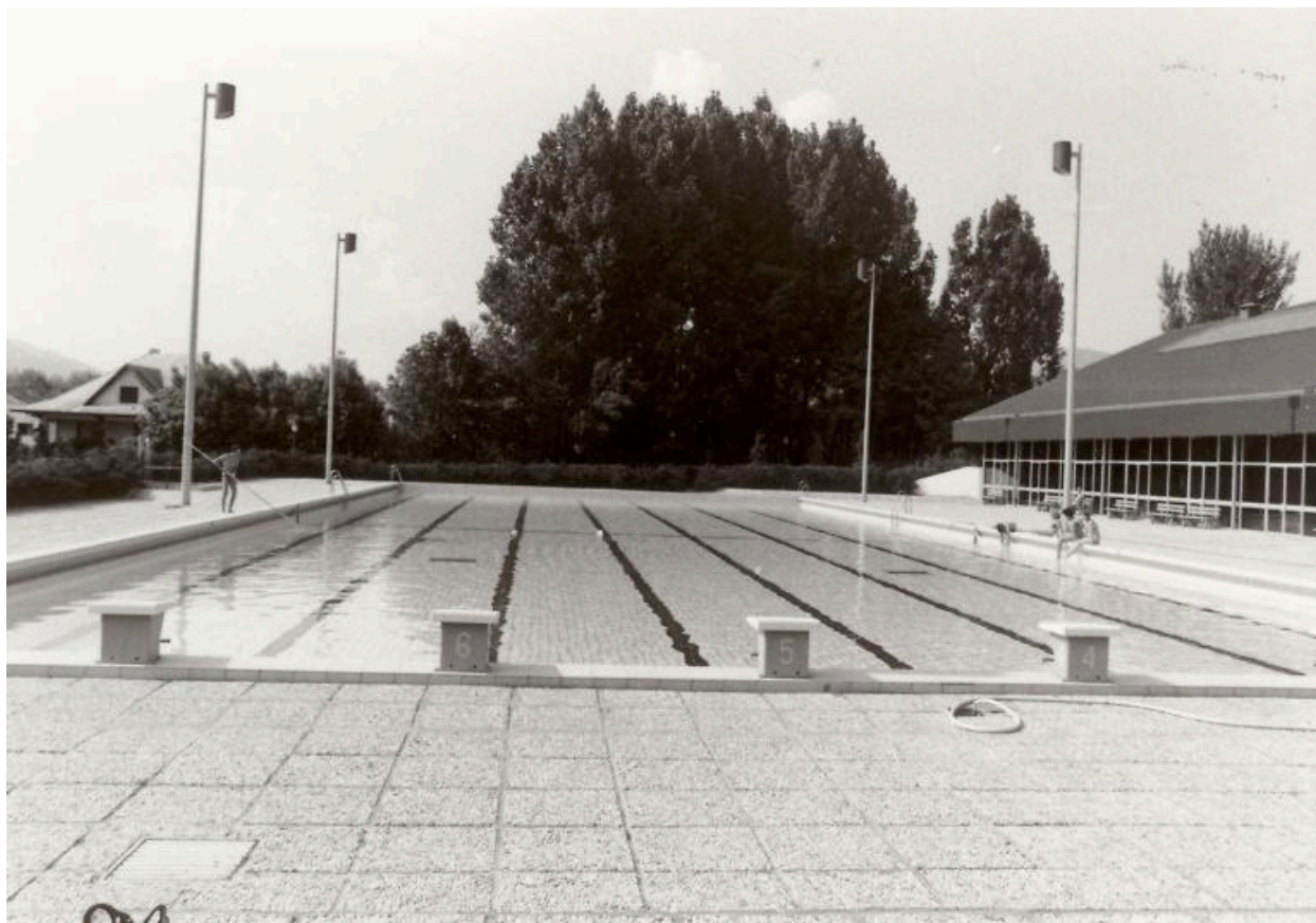
Bassin olympique extérieur avant travaux
