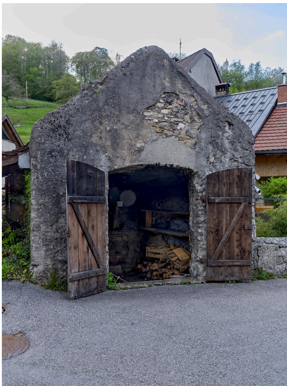
Vue du four ouvert.
