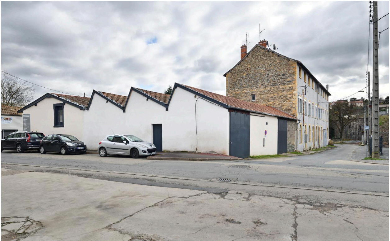
Ateliers sheds connexe à la maison-séchoir
