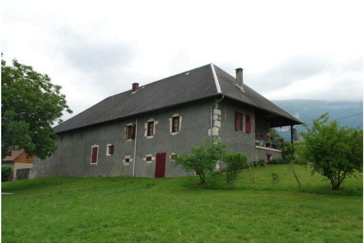
Vue d'ensemble depuis la D 911.
