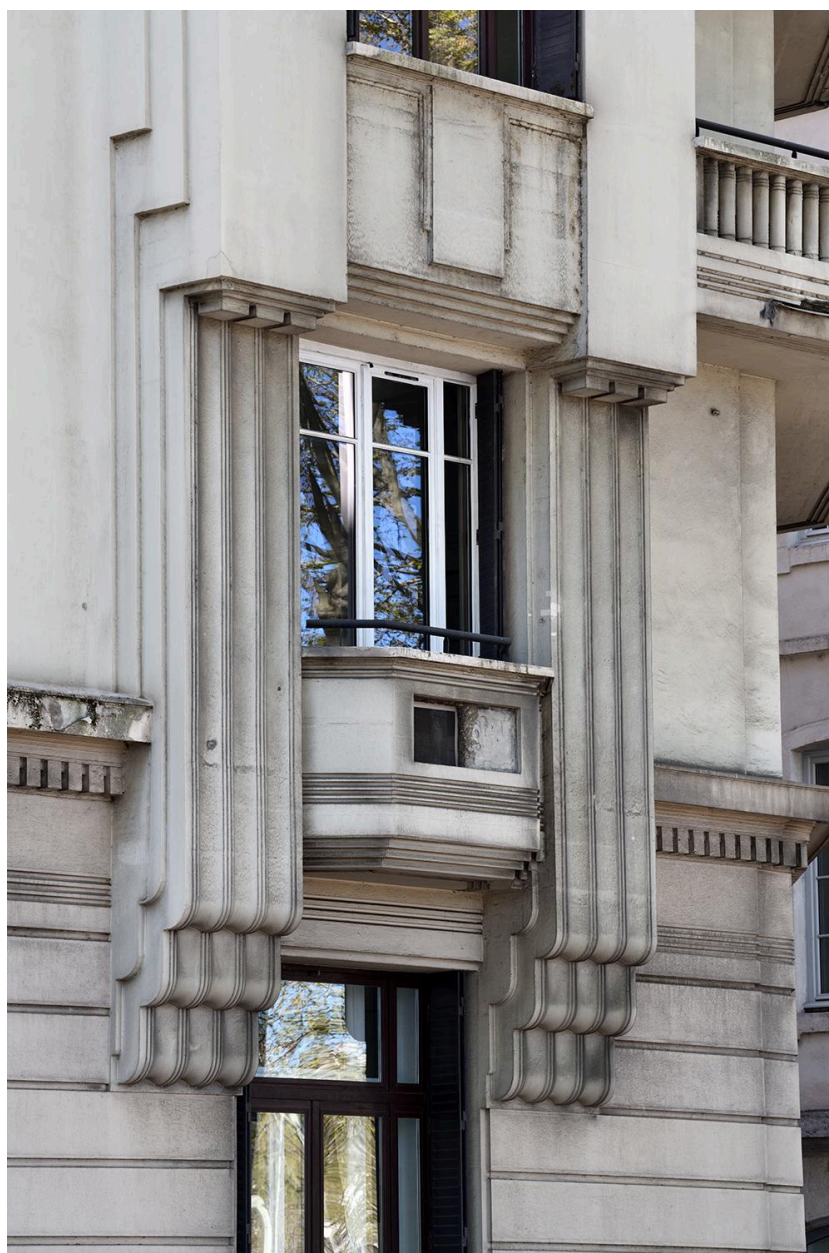
Bureaux des soieries Rosset : détail façade
