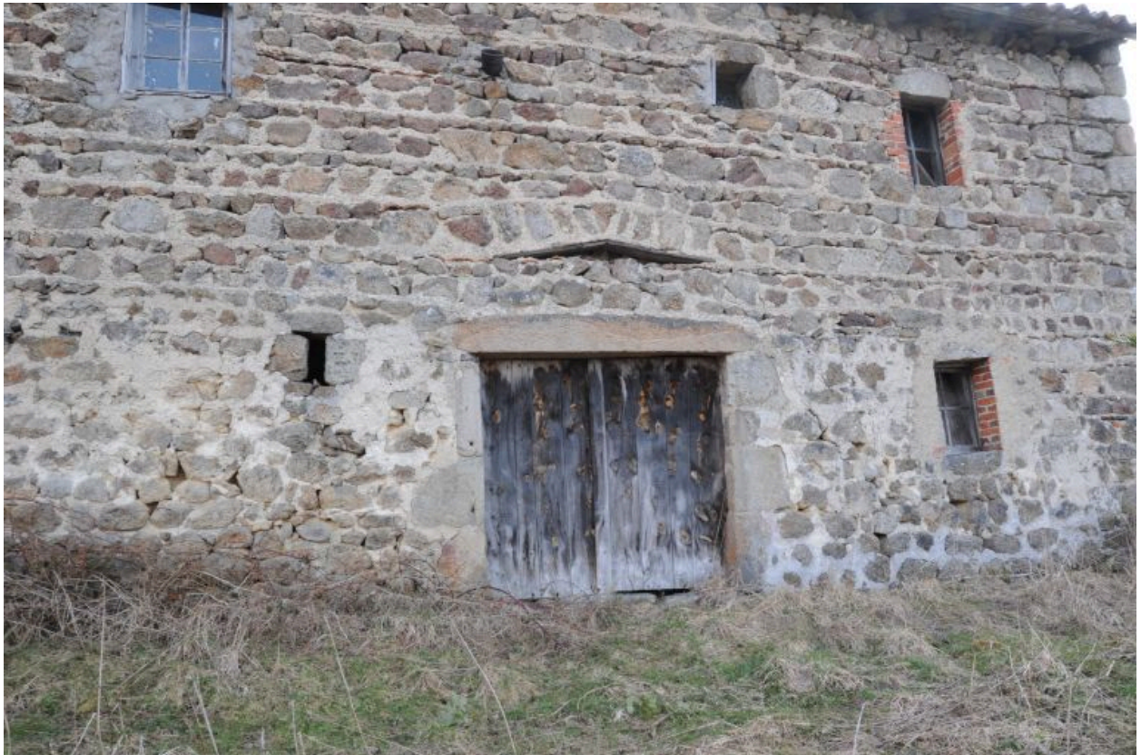
Mur pignon sud, détail des baies.
