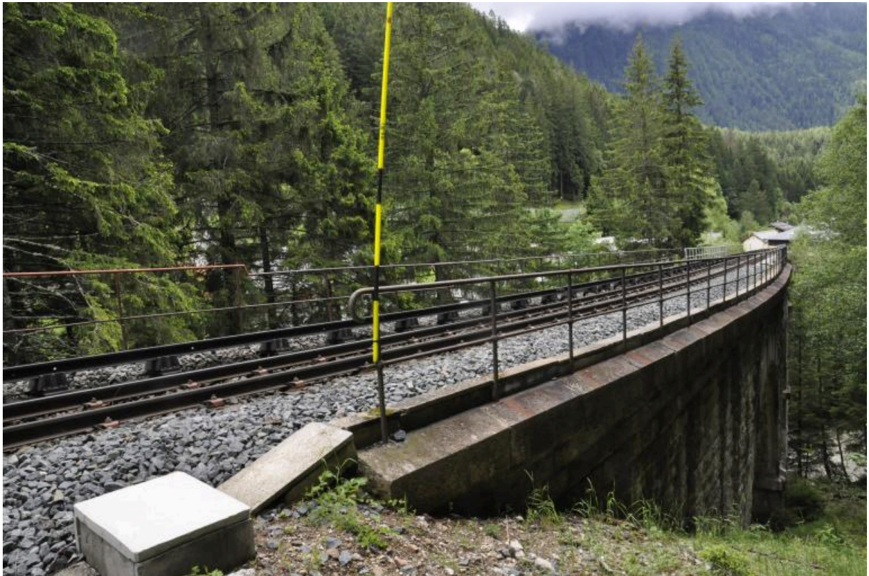
Détail de la voie ferrée et des plinthes maçonnées couronnant la face avale du viaduc
