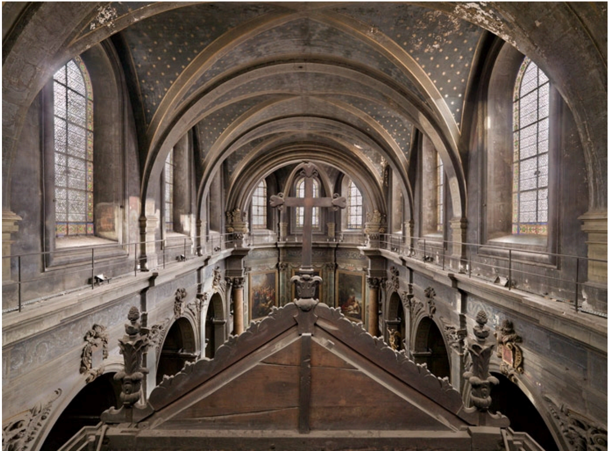
Intérieur : les voûtes depuis la galerie
