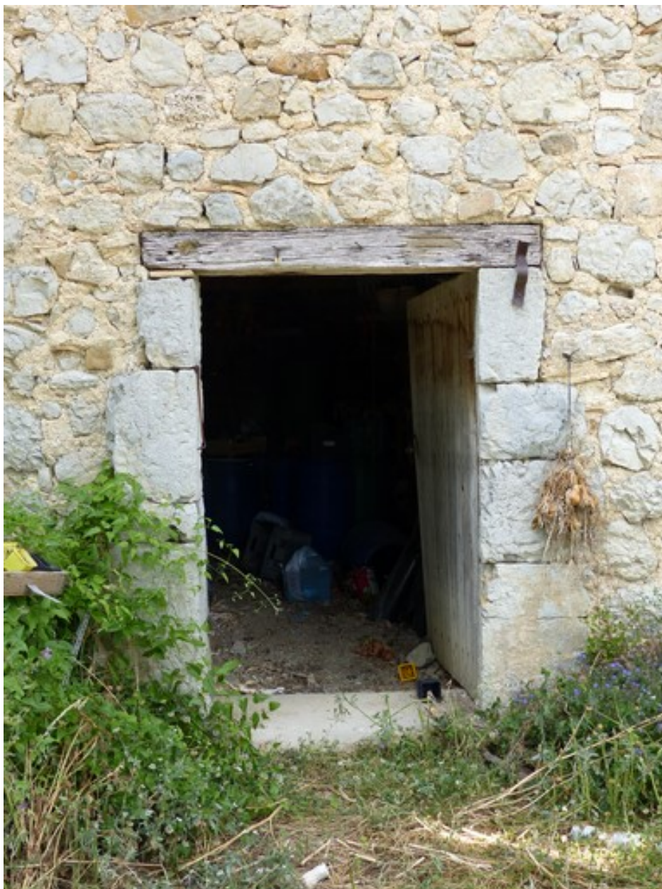
Porte d'étable en pierre de taille calcaire et linteau monoxyle, ferme à Baïs.
