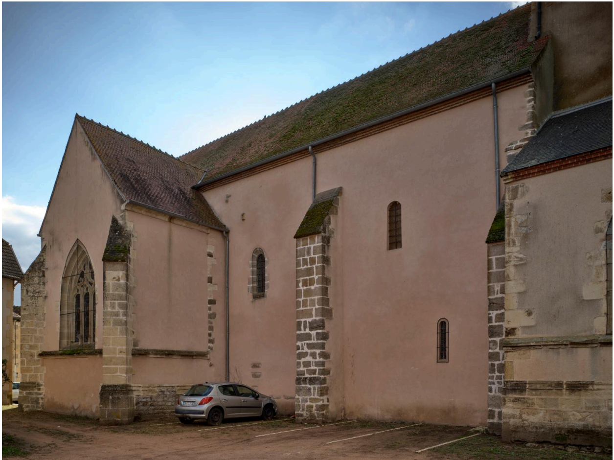
Chapelle du 15e siècle, mur gouttereau de la nef et chapelle du 16e siècle côté nord.
