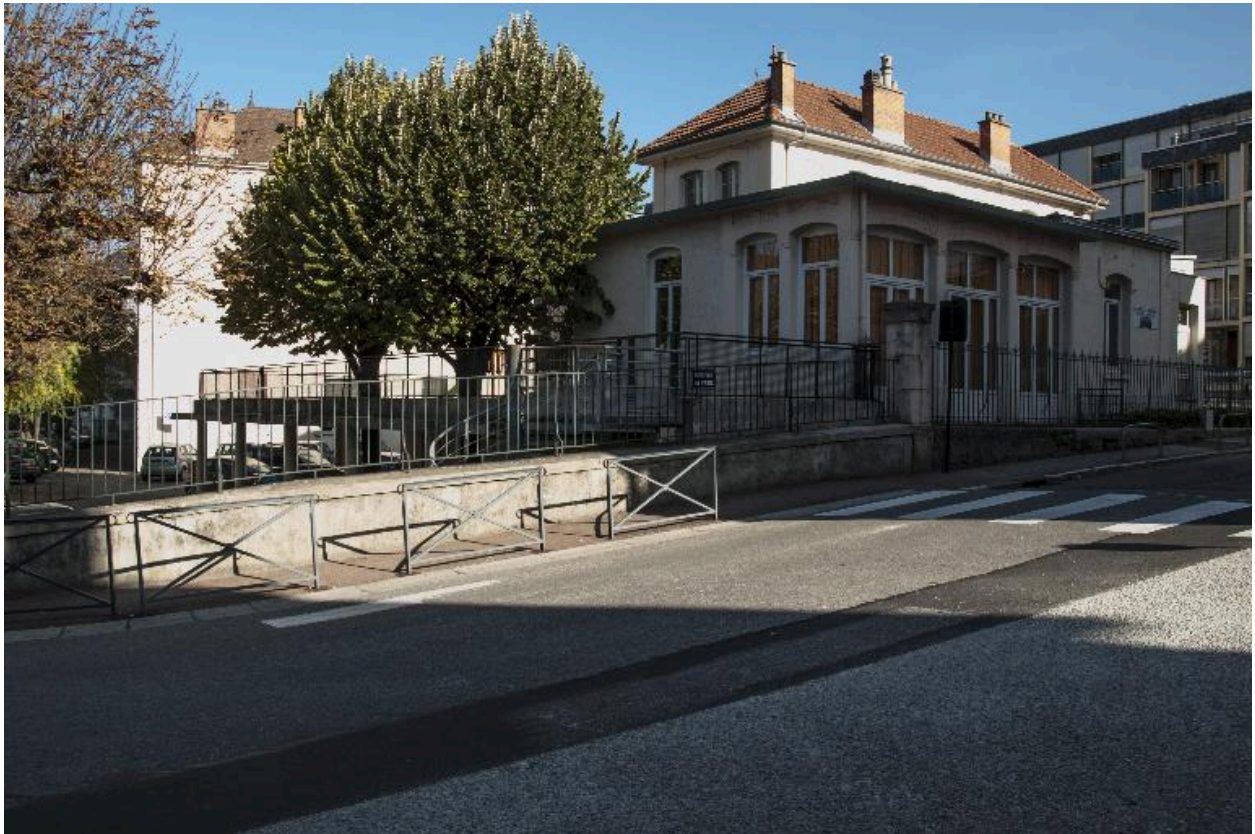
Vue depuis le sud-ouest
