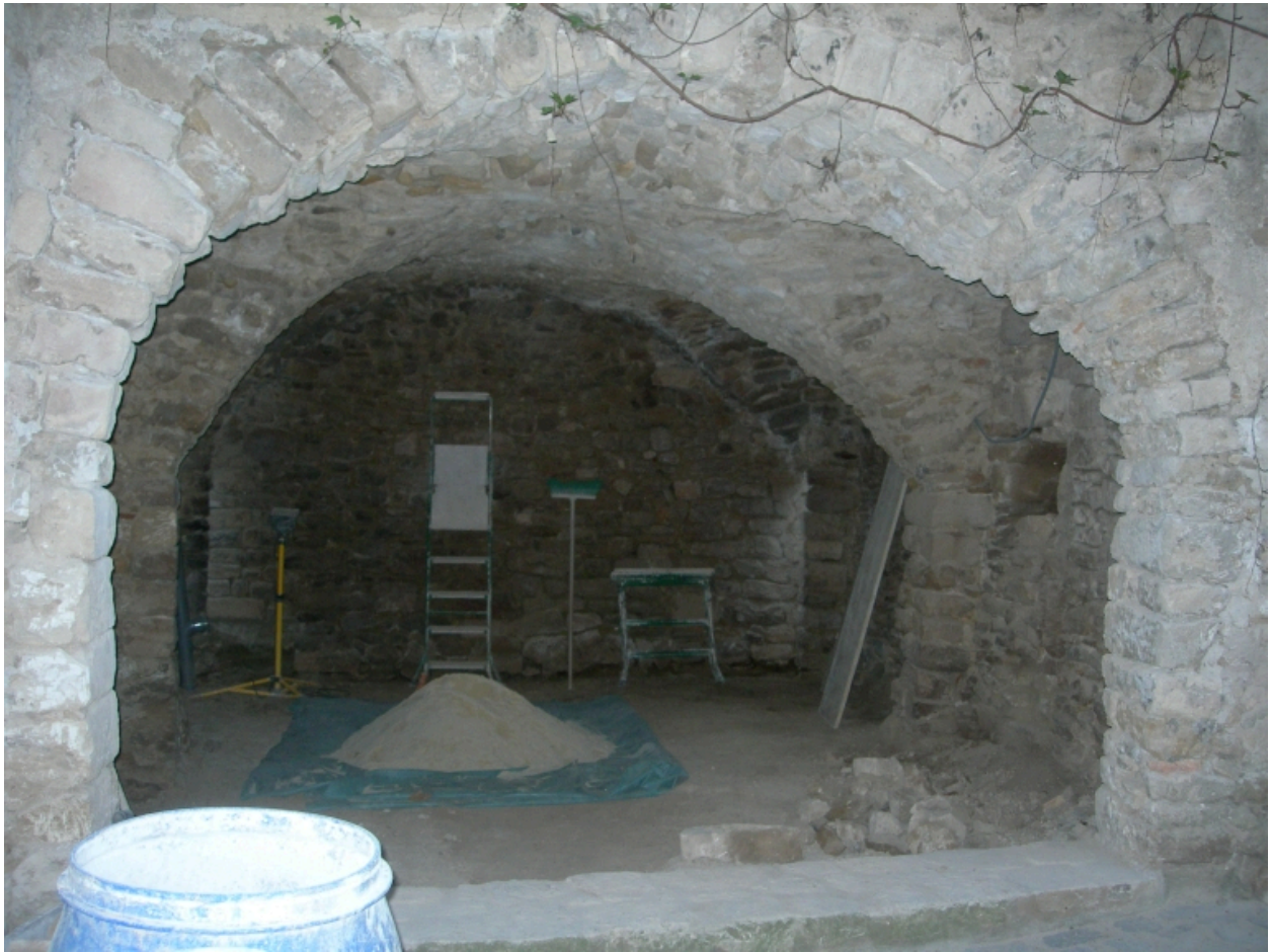
Dépendance voûtée d'arêtes, au 1er niveau, ouvrant sur la cour intérieure de gauche (parc. D 196).
