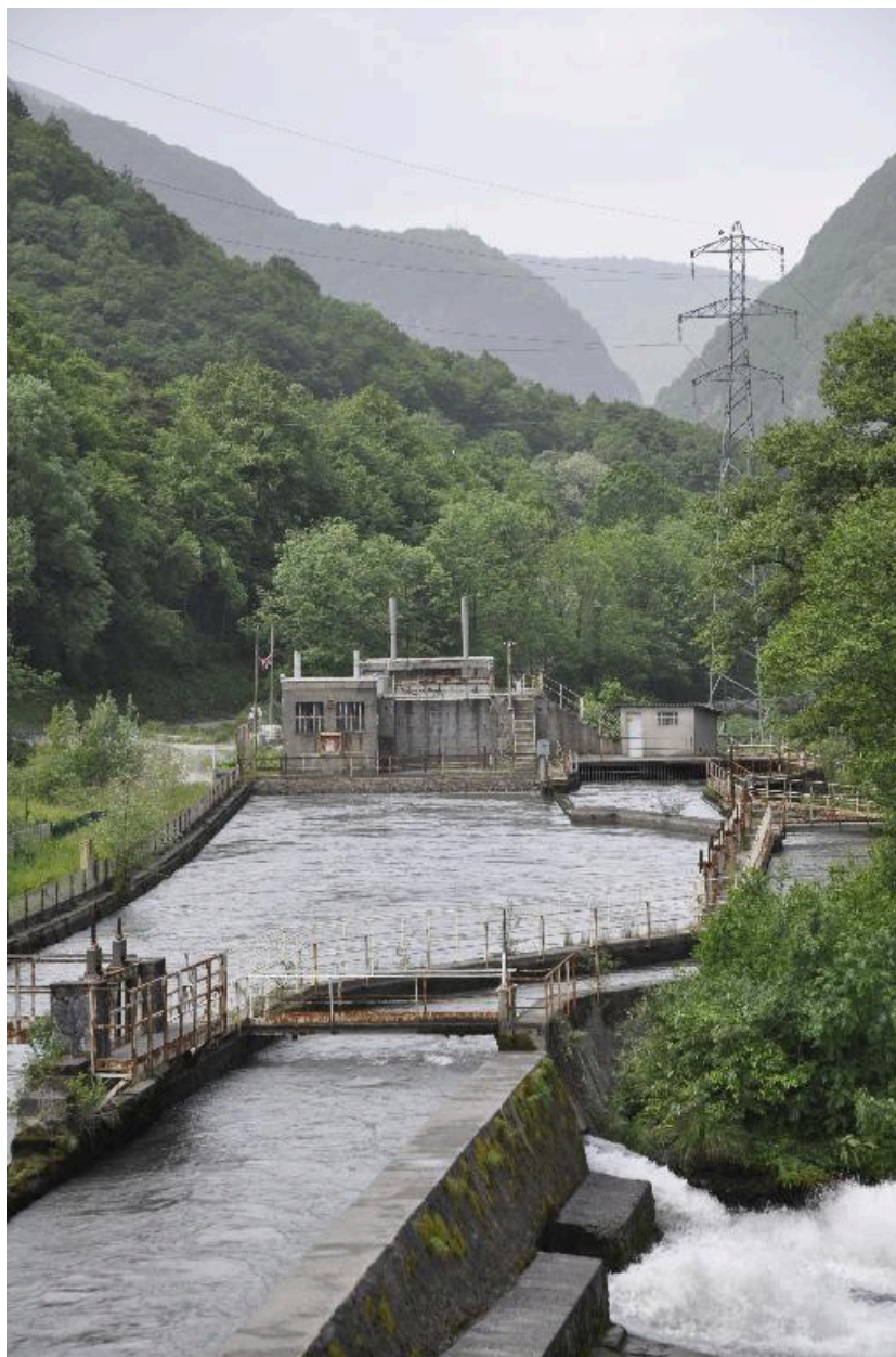
Vue aérienne du barrage
