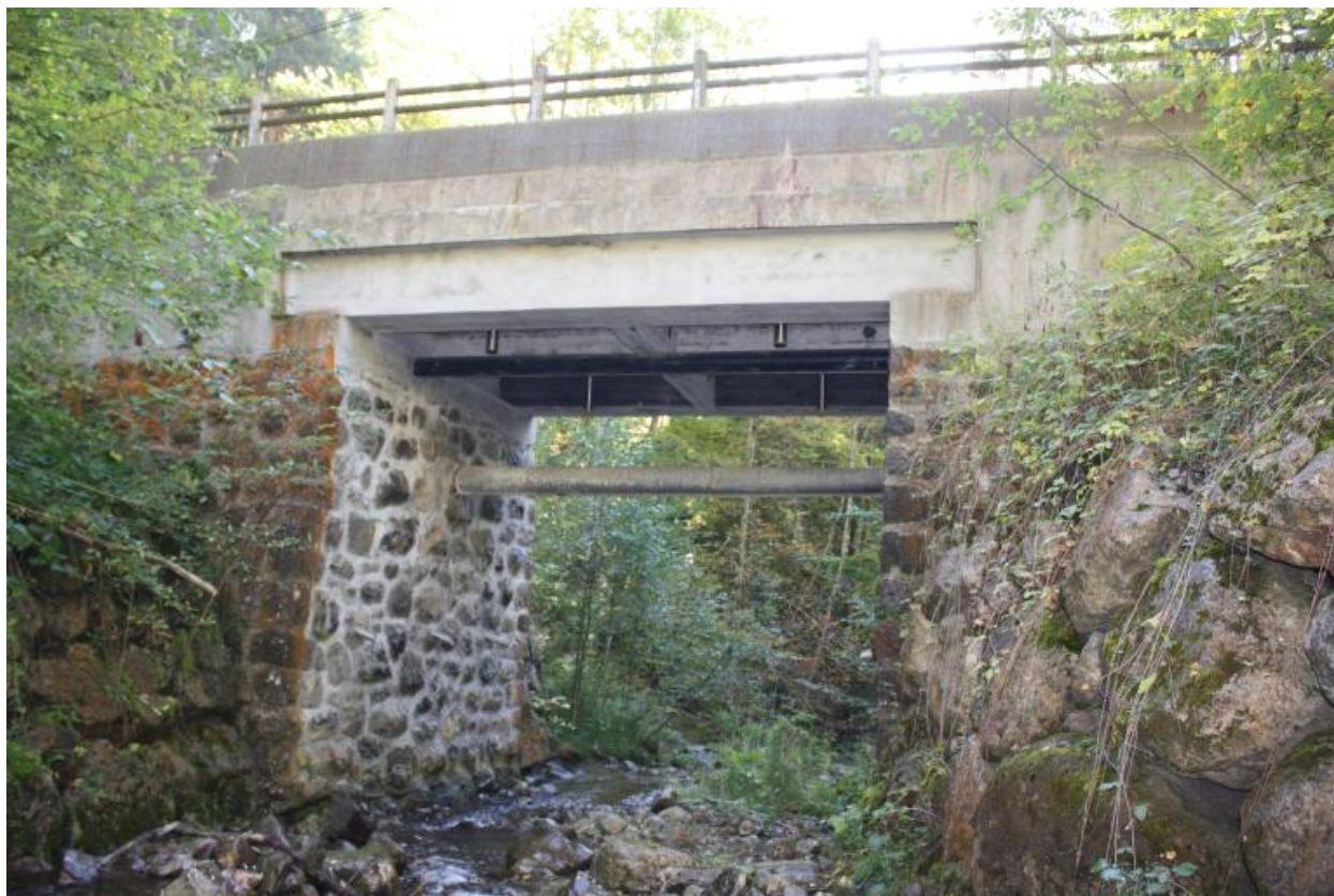
Pont des Onchets, face amont
