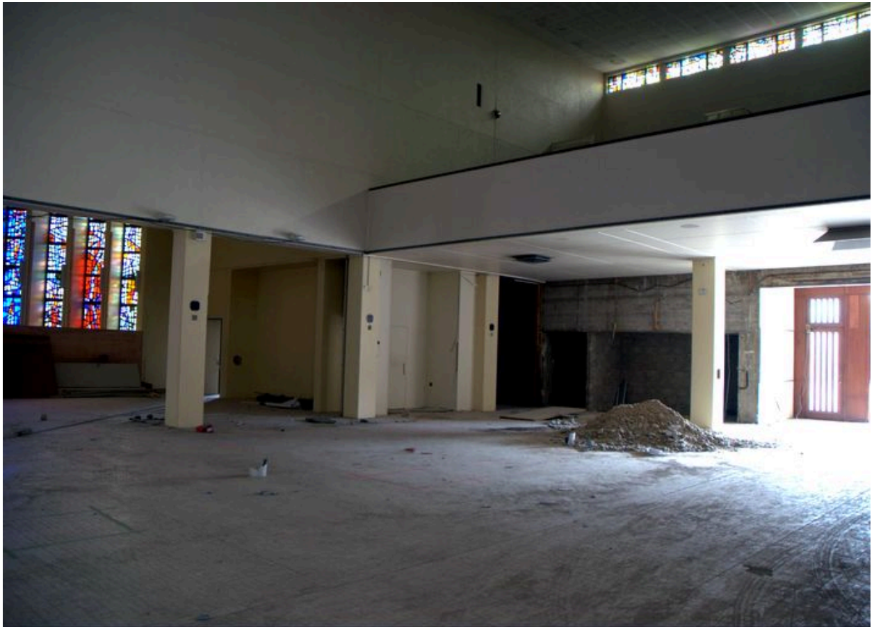
Intérieur de l'église depuis le sud-est, chantier en cours, mai 2008
