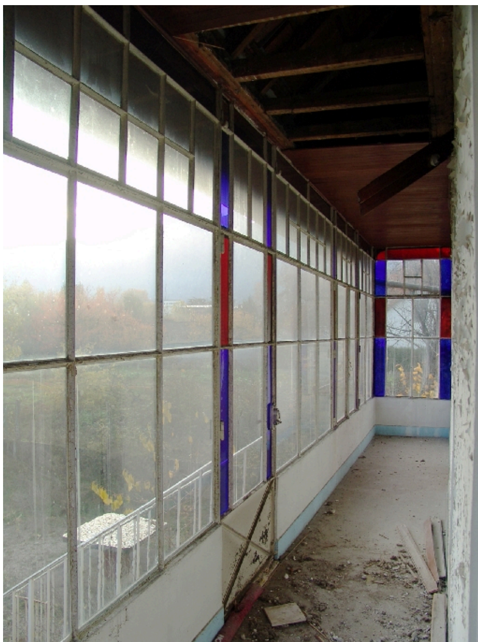
Galerie vitrée au sud
