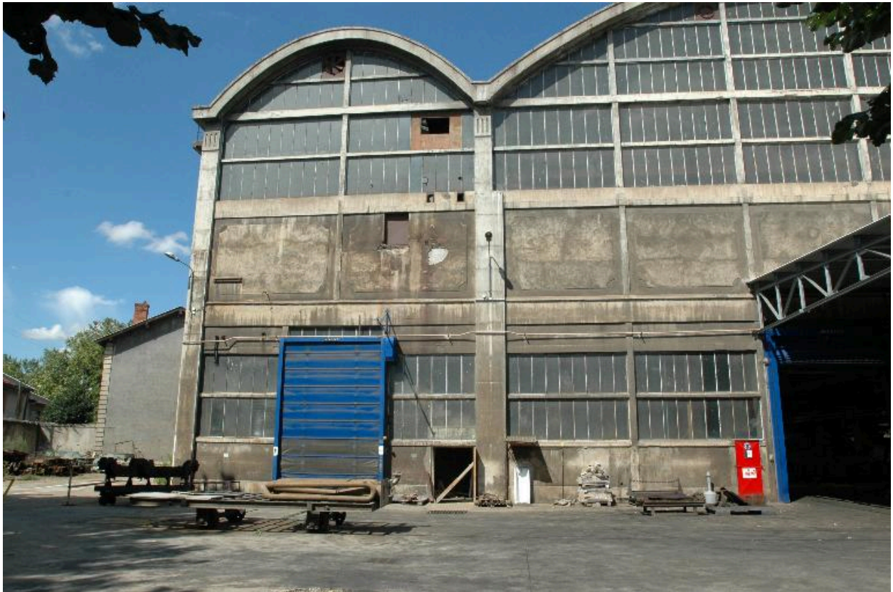
Vue extérieure des double halles
