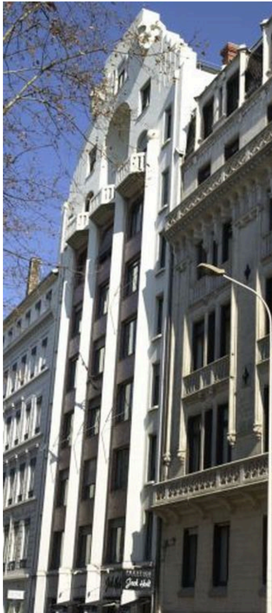
Vue de l'élévation sur rue depuis le sud-ouest
