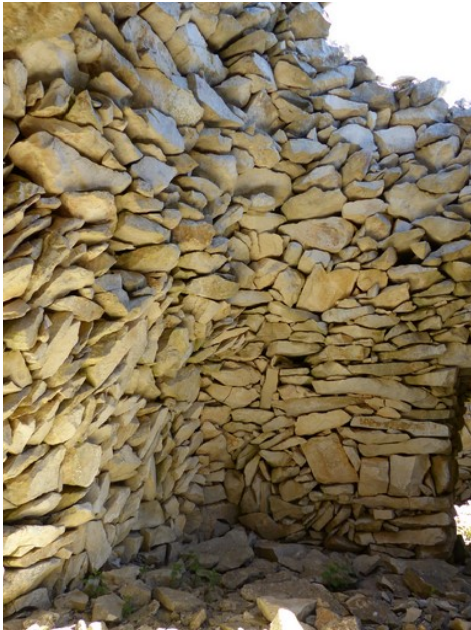
Travée centrale. Angle nord-est, coupole encorbellée sur maçonnerie clavée.
