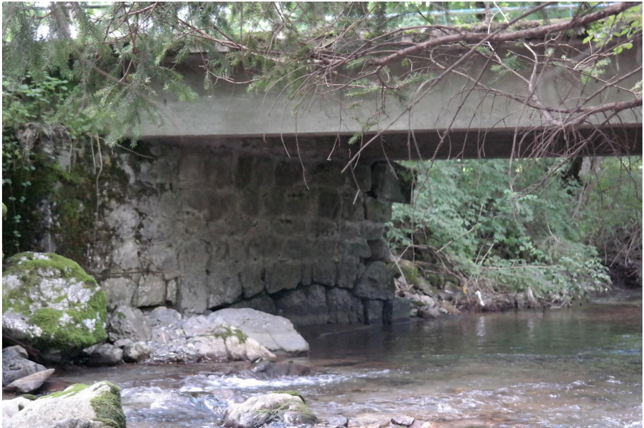
Pont du Moulin, détail culée
