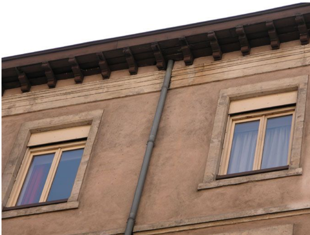
Détail de l'avant-toit
