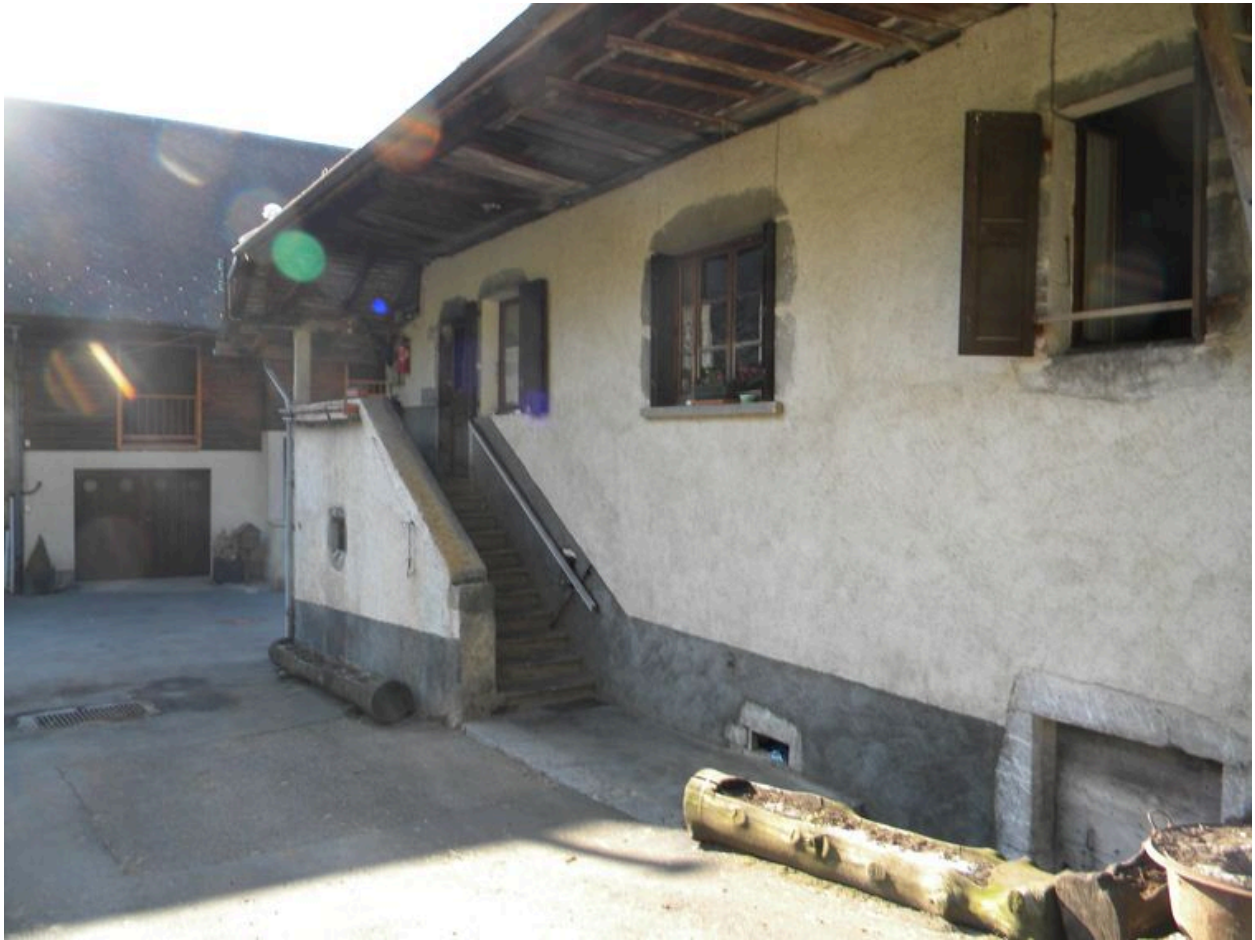
Vue de la montée d'escalier en façade.
