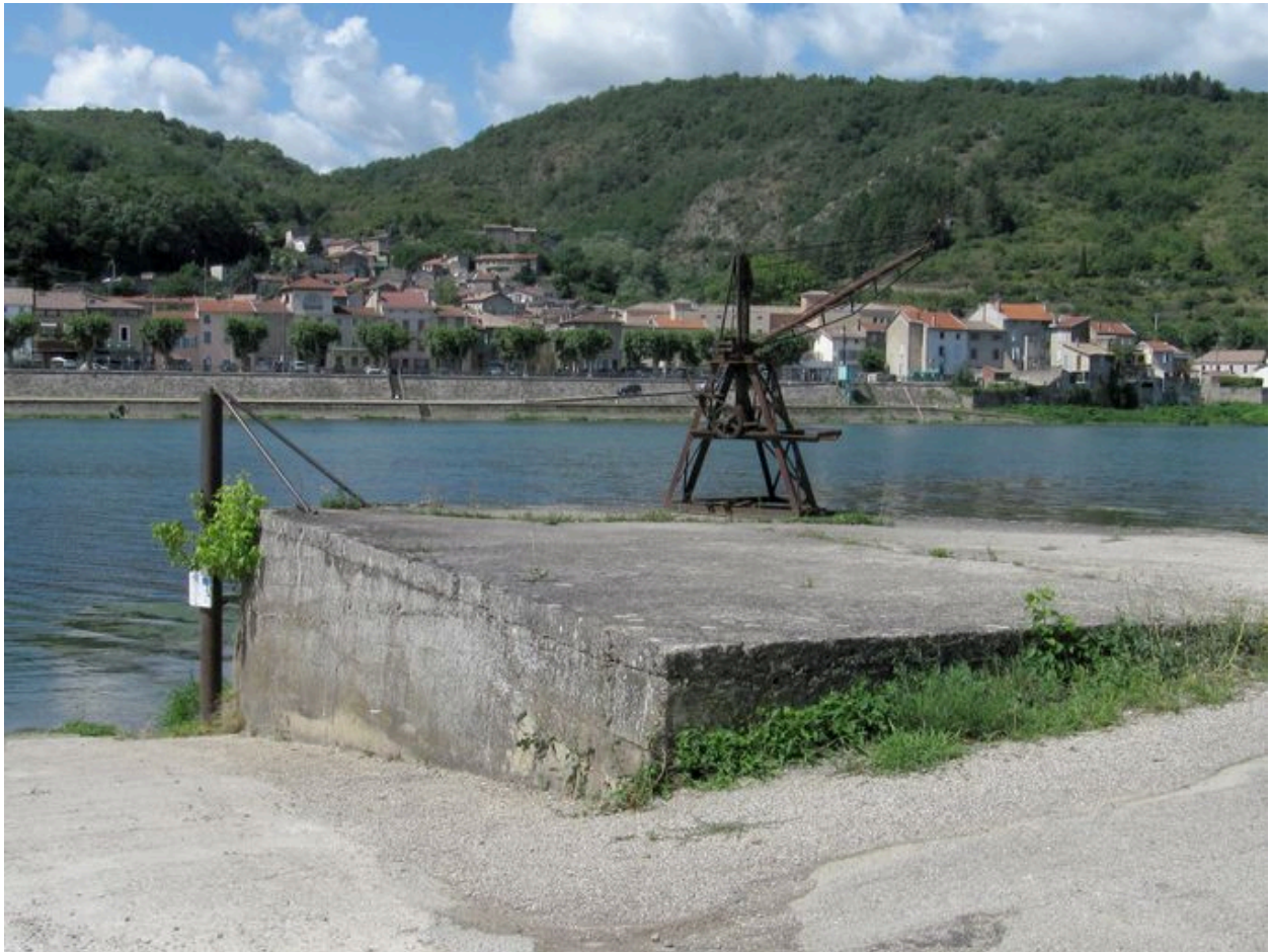
Vue de l'emplacement supposé de l'ancienne traille de Serrières ; vestige de treuil
