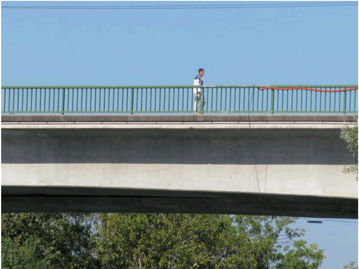
Tablier et parapet, vue partielle, face amont (depuis la rive droite)
