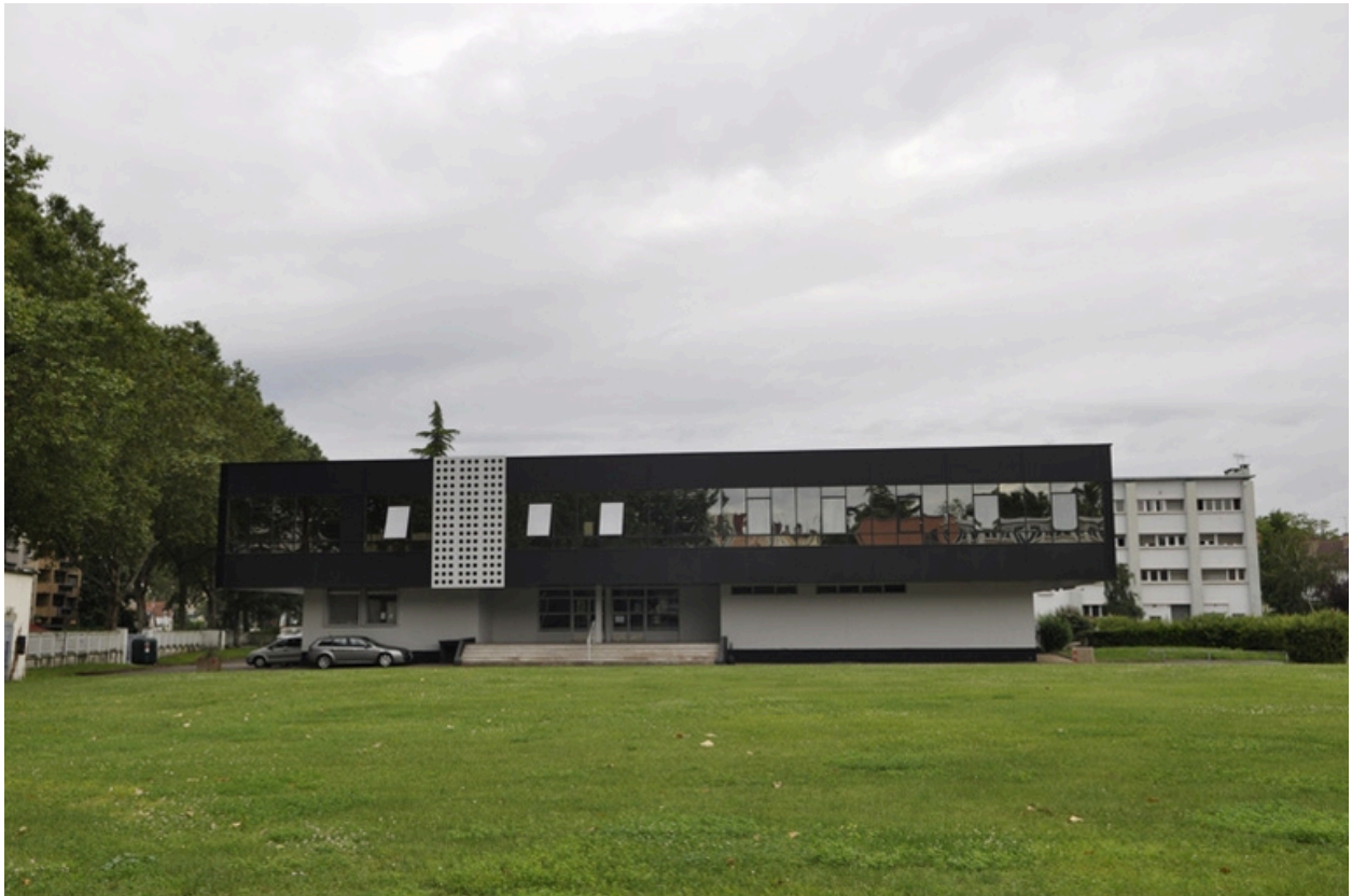
Vue du réfectoire construit dans les années 70 et réhabilité dans les années 2000. Façade sud.
