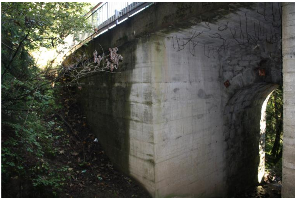
Pont de la Panosse, détails culées et voute
