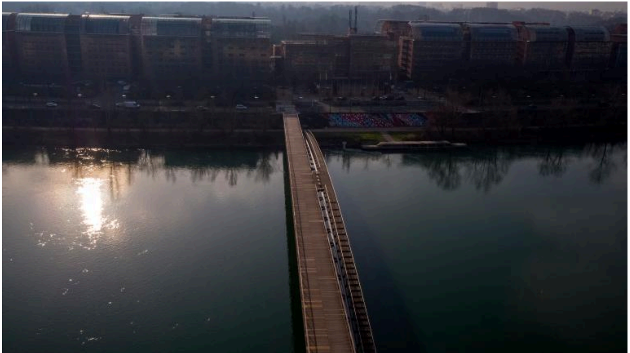
Vue d'ensemble ouest de la passerelle de la Paix (drône)
