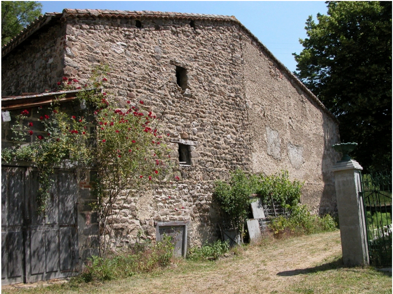
Vue d'ensemble du bâtiment de dépendances, depuis le sud-ouest.
