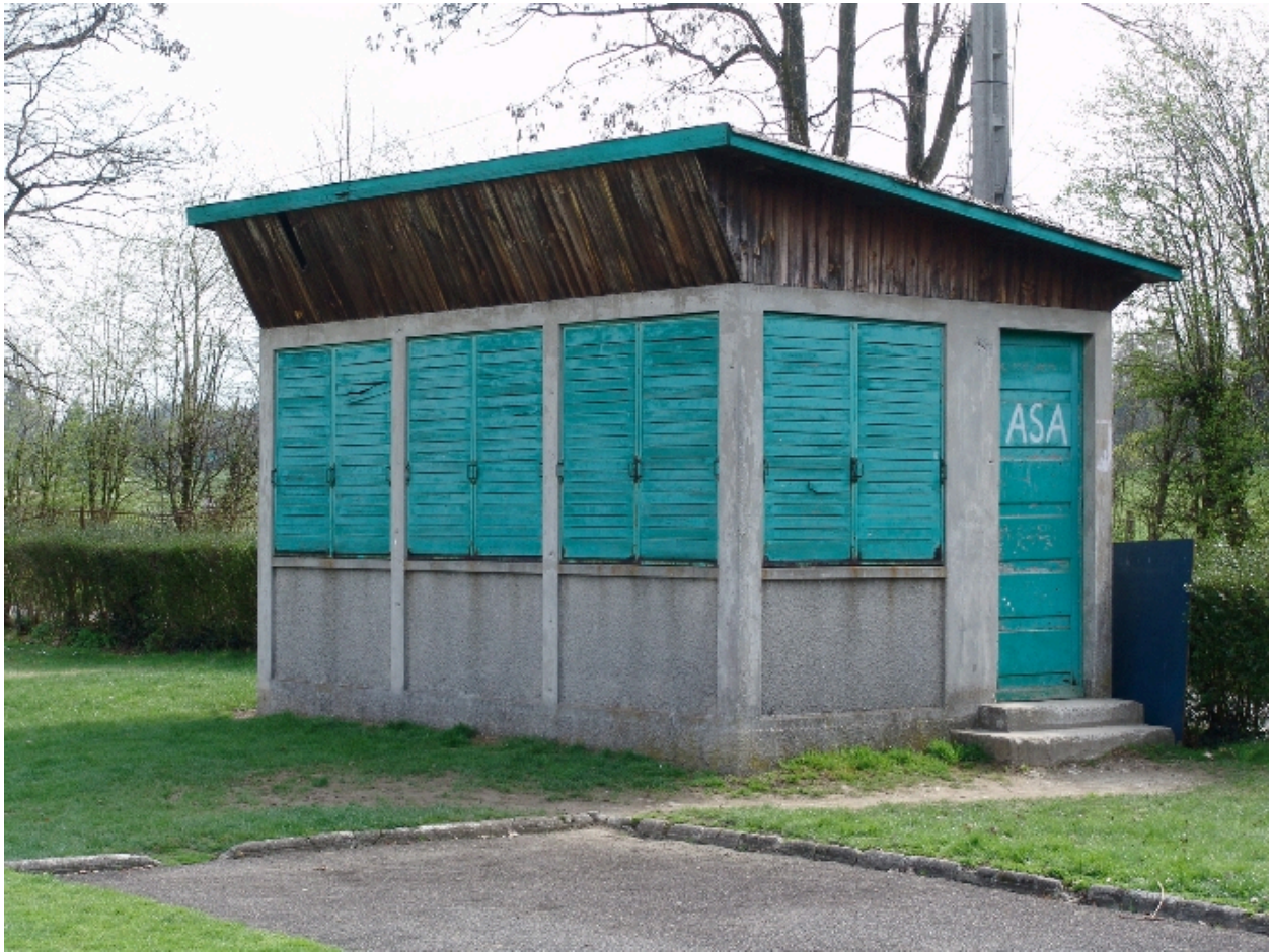
Bâtiment de chronométrage
