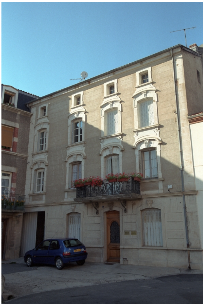
Boën, îlot 16, Gare (rue de la) 5. Vue générale de la façade sur rue.
