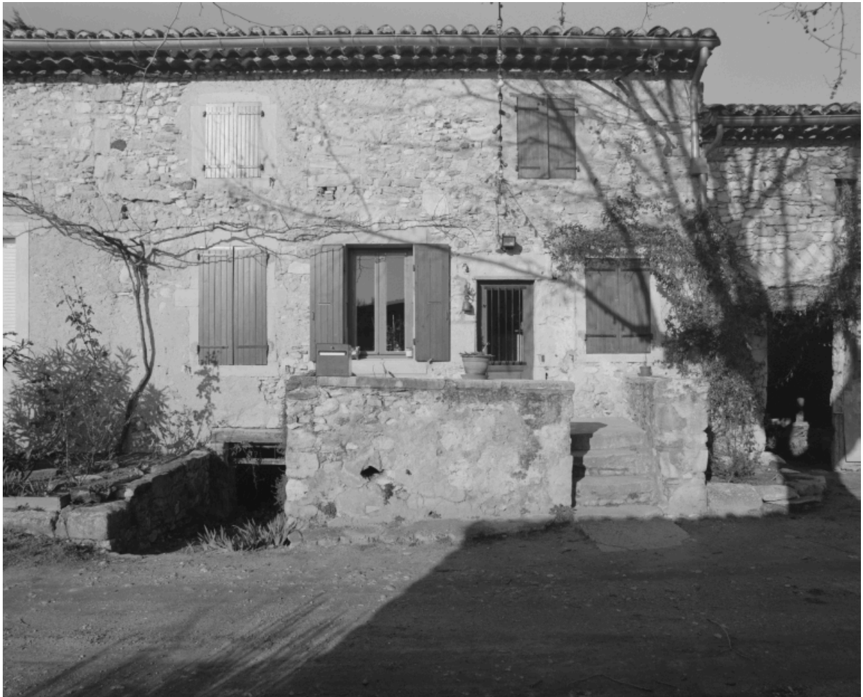
Vue partielle de l'élévation principale, montrant le logis le plus ancien.
