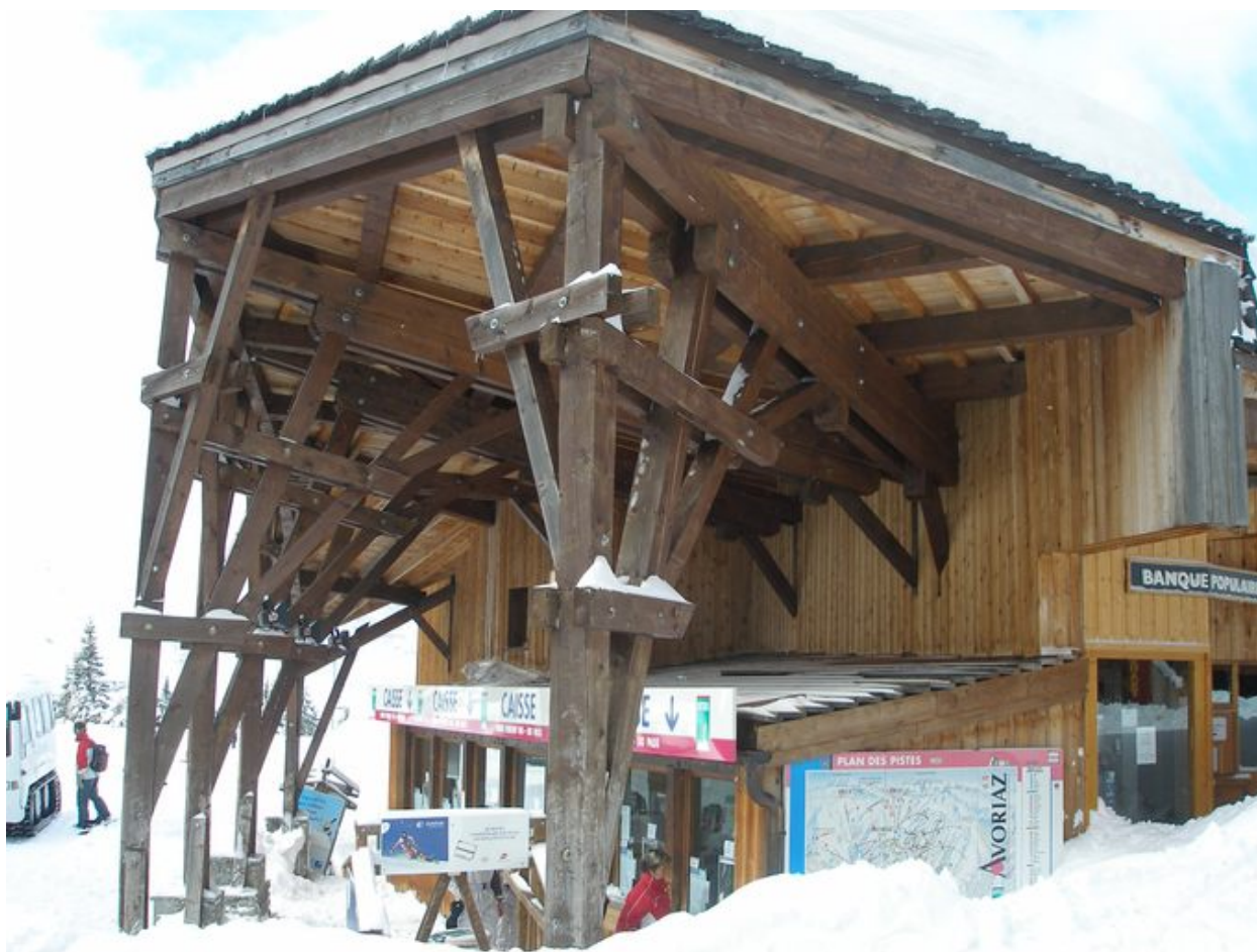
Le pignon sud
