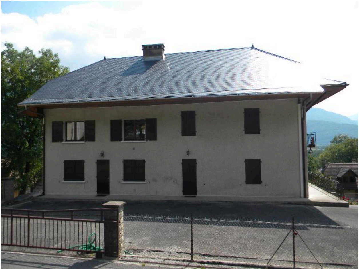
Vue d'une ancienne ferme modifiée (2008 B2 1957, 1958).
