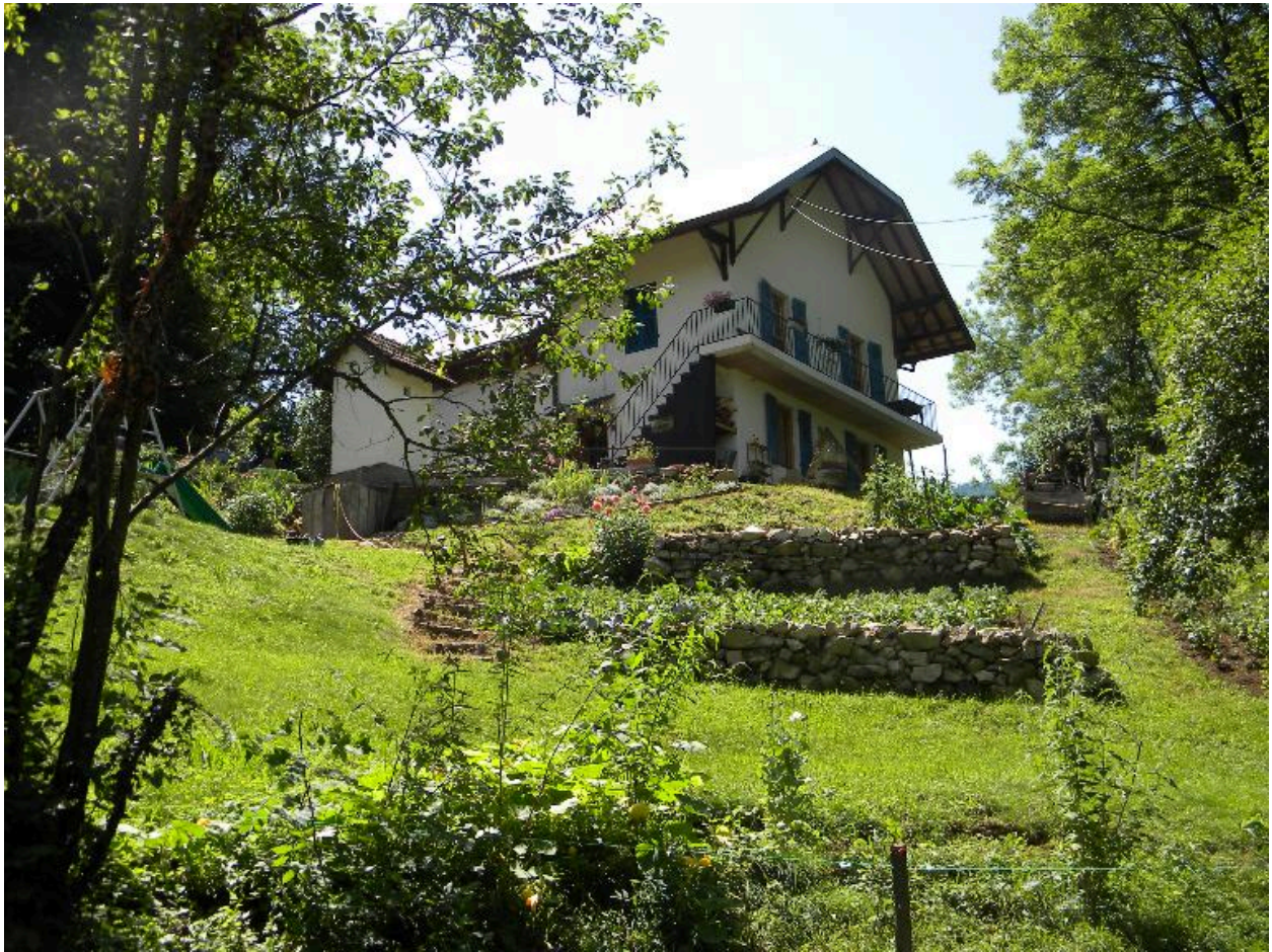
Vue d'une maison modifiée (2008 D9 1835).
