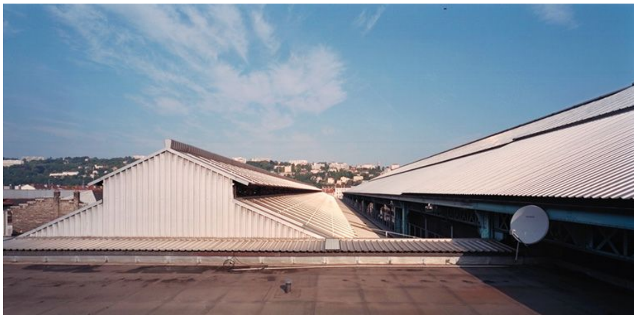
La couverture des deux halles depuis le toit de la passerelle de l'est vers l'ouest
