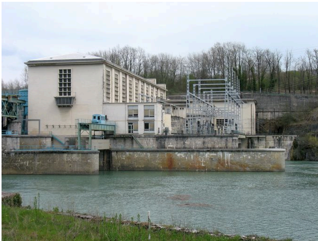
Vue de l'usine hydroélectrique depuis la rive droite (ouest)
