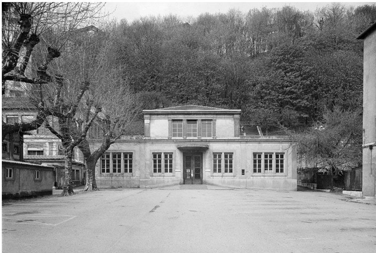
Bâtiment de clinique, façade principale
