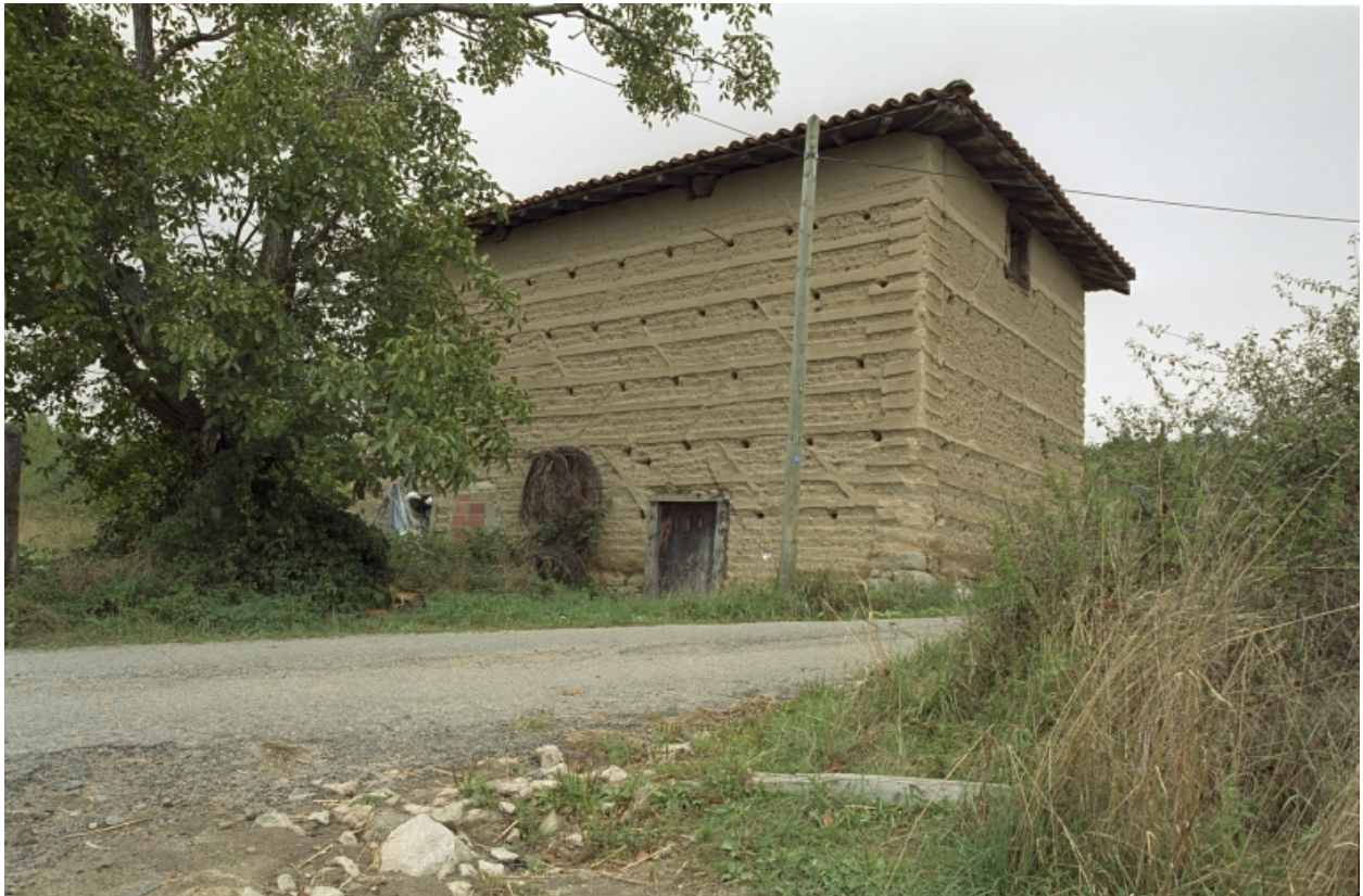
Vue d'ensemble de la grange étable située à l'entrée du hameau au nord-est, depuis l'ouest.
