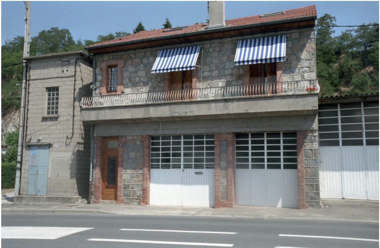
Boën, îlot 17, RN 89, 2. Vue générale de la façade sur rue.
