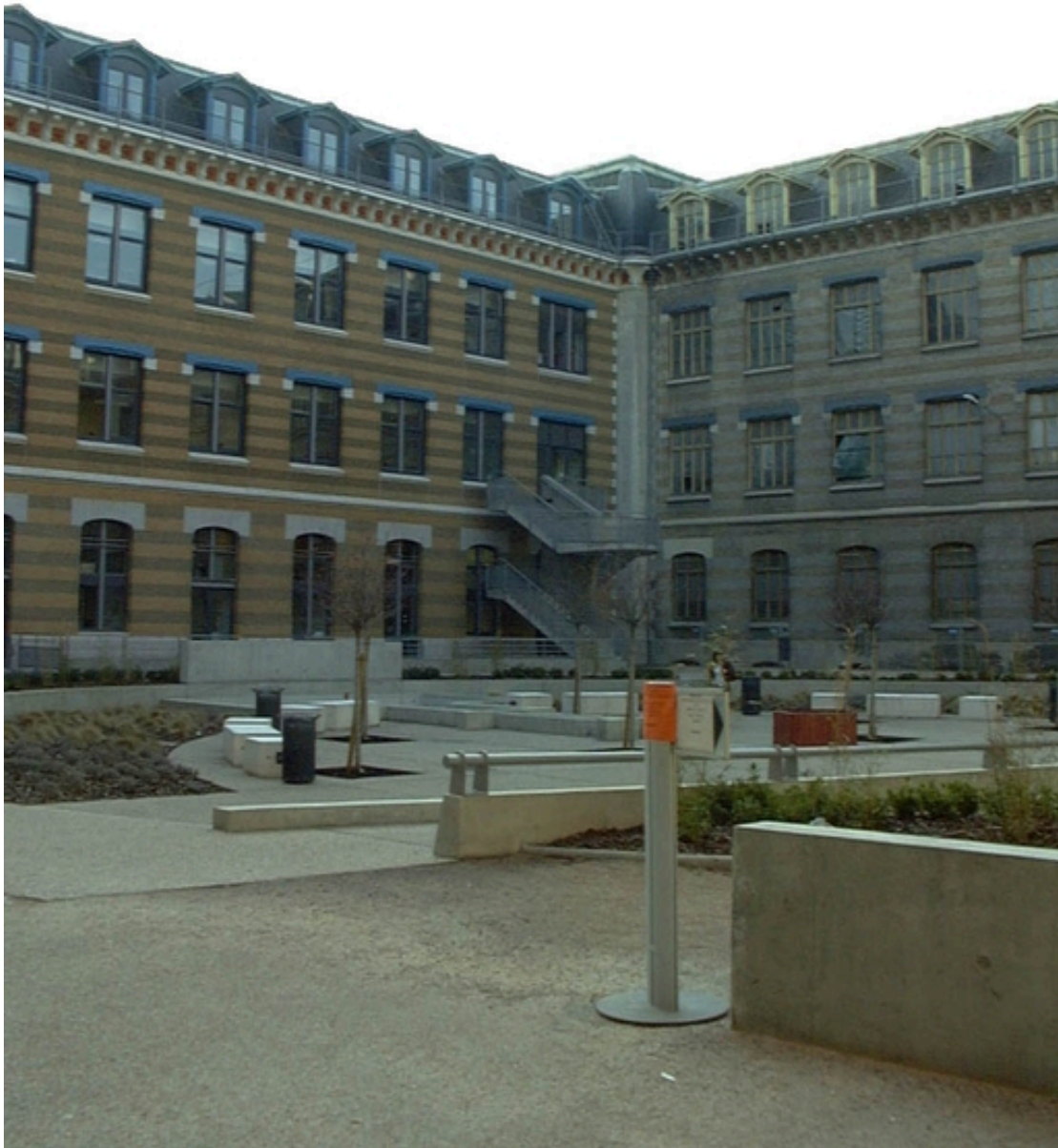
Détail cour, escalier de secours
