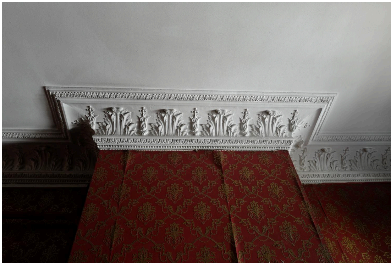
Moulure en stuc, salle au manger du rez-de-chaussée
