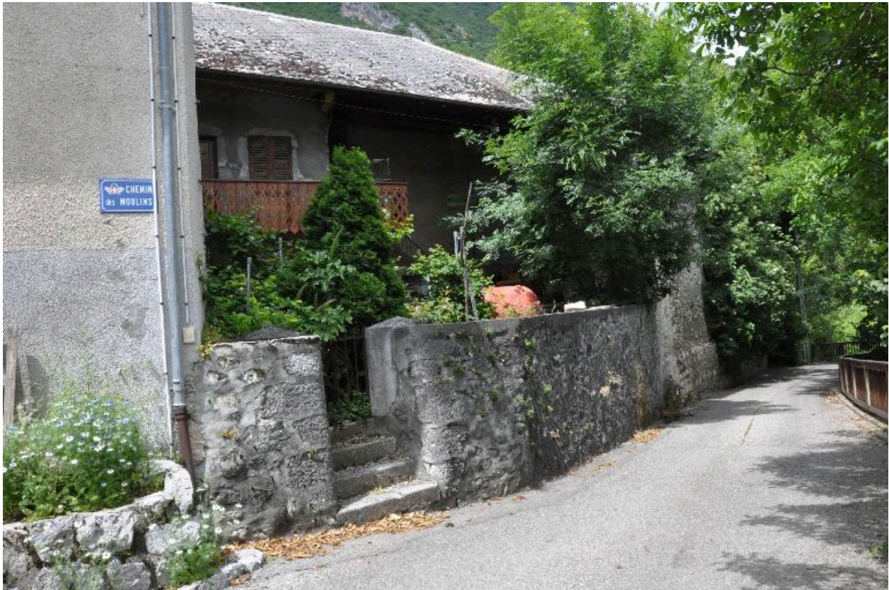
Façade est du moulin Paccard.
