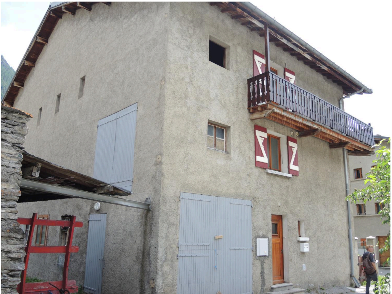
Détail façade est maison n° 17 : porte d'étable
