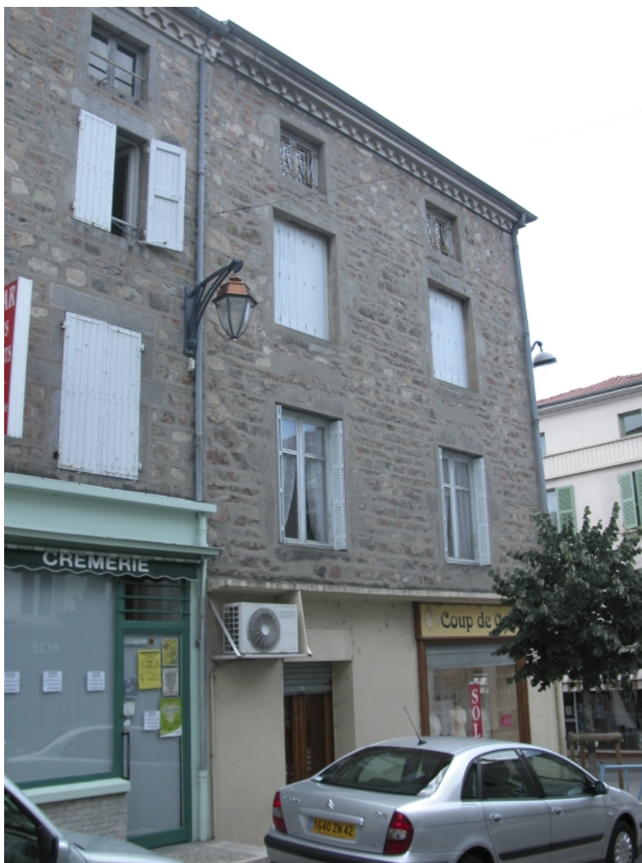
Îlot 1. République (place de la) 05. Vue d'ensemble de la façade sur la place.
