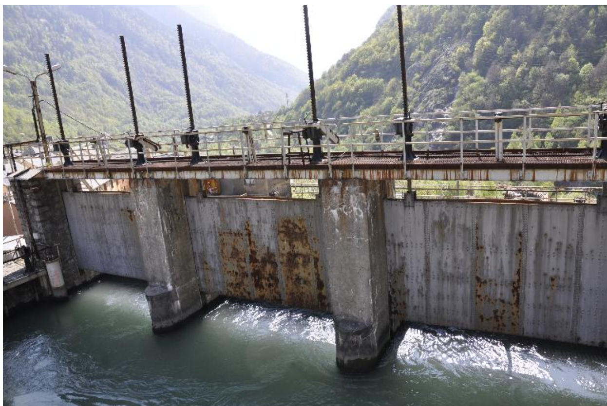
Vue du barrage
