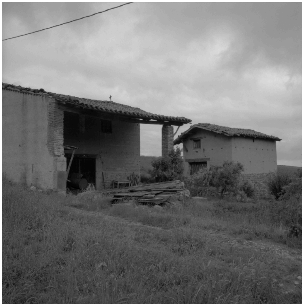
Vue d'ensemble depuis l'ouest.
